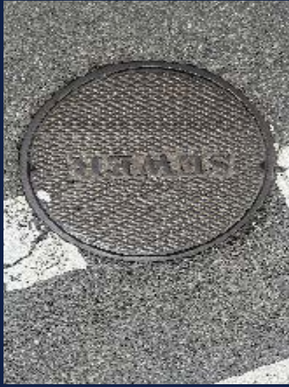
Agujero de mantenimiento en Harding St. que conduce hacia el sistema de alcantarillado combinado de Worcester
